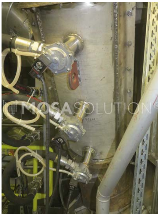
Obrázek 9 – Nové řešení a pulzní trysky na svodce [1]
