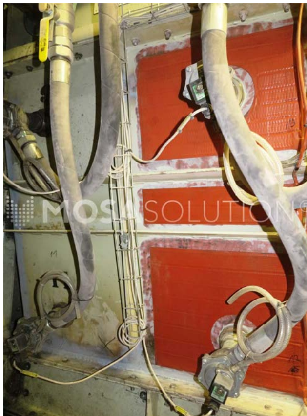
Obrázek 6 – Kombinace pulzních trysek a topného systému [1]
