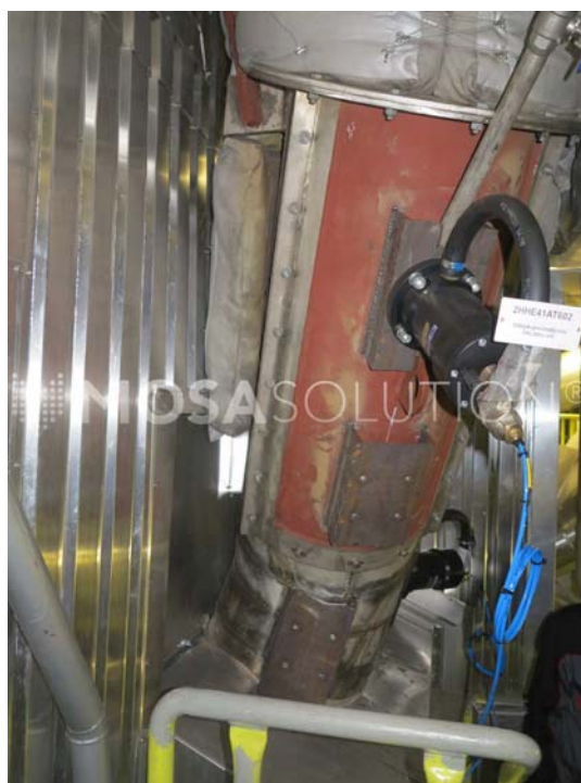
Obrázek 8 – Vibrační kladivo na svodce [1]
