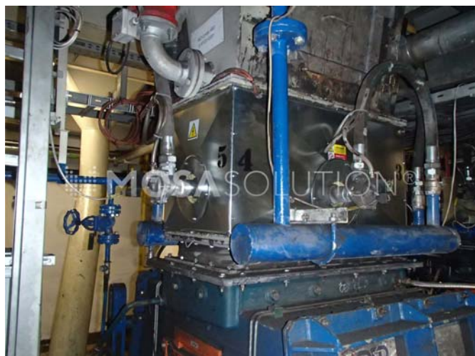
Obrázek 7 – Silikonové topné rohože jsou zaizolovány [1]
