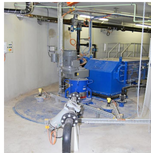
Dávkování EGS do rozplavovací nádoby
