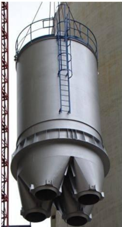
Provozní silo vápna
