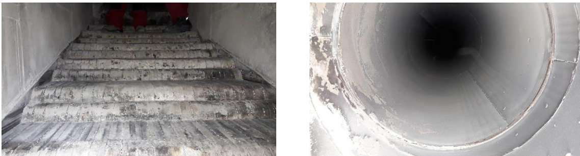
Obr. 2 Stav technologie po roce provozu (rošt, spalinovody)
