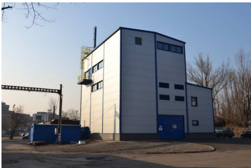
Zkušební spalovací zařízení
