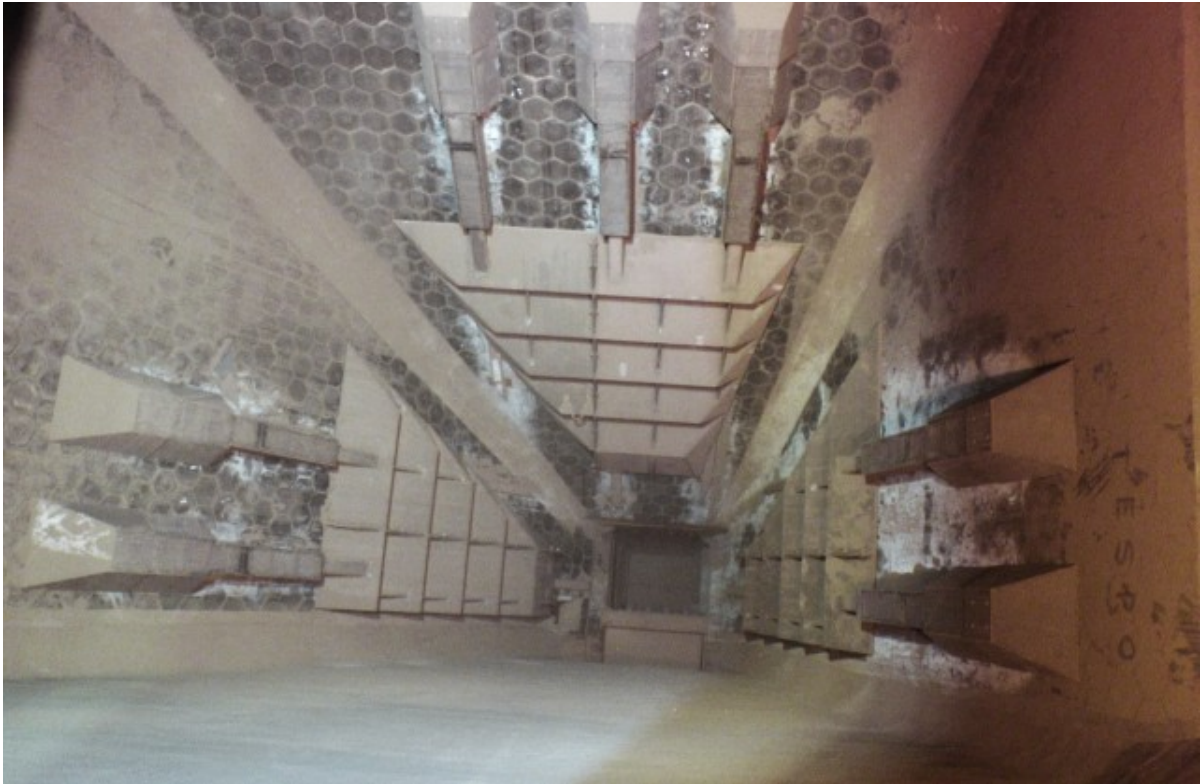
Obr 11.: Pohled z násypné strany zásobníku na instalaci rozrušovacích hrabel na šikmých stěnách
