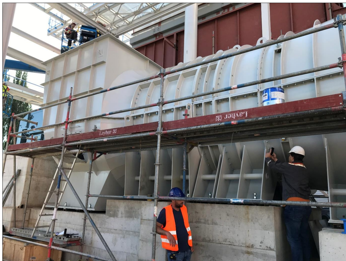
Obr. 8 Axiální ventilátor – montáž
