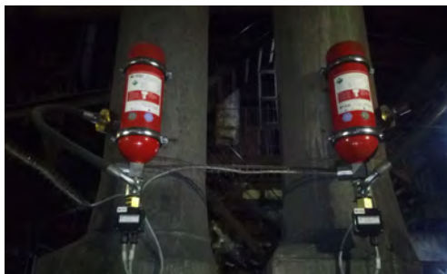
Způsob ochrany dopravních cest a mlýnského okruhu. Foto zdroj: RSBP spol. s r.o.
