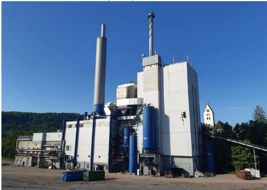
Obrázek 1 Relokovaná elektrárna v Albruck (Německo)
