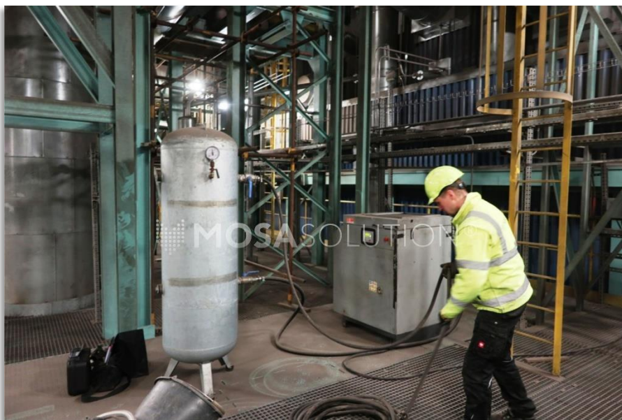
Montáž kompresoru a vzdušníku
