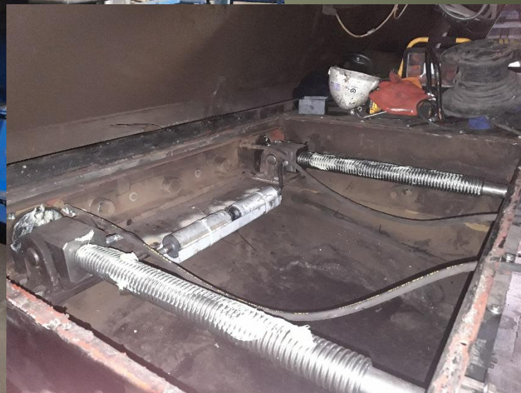
Mondi Štětí Revize a oprava deskových uzávěrů K11
