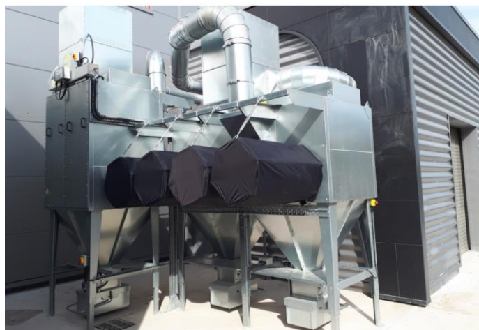
Obrázek 7: Příklad zařízení na bezplamenné odlehčení výbuchu
